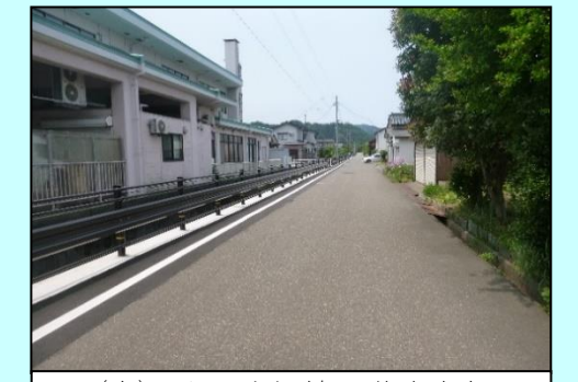
(市)ぬな川大坪線 道路改良 (基幹事業 道路)
