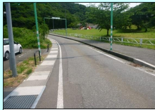
(市)三峯線 側溝改修 (基幹事業 道路)
